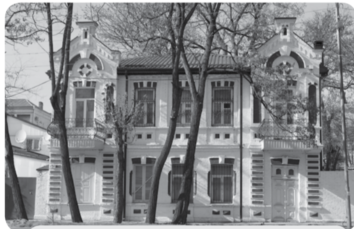
Дом № 54 по улице Октябрьской в Пятигорске после капремонта. Фото: минЖКХ СК.
