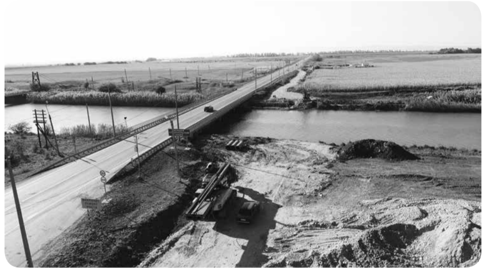
Строительные работы на на магистральном канале БСК.
