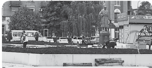
Через несколько дней рабочие завершат укладку тротуарной плитки, площадь наполнится малыми архитектурными формами и зелеными насаждениями.
