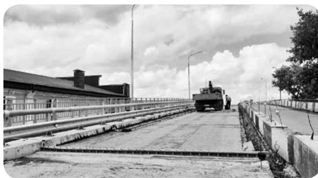
Самая сложная часть работ на путепроводе выполнена.
