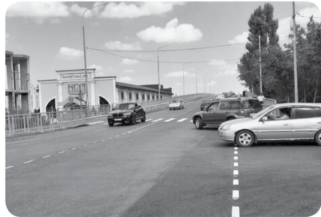
В 2021 завершён ремонт путепровода на улицах Железноводская - Ломовая.
