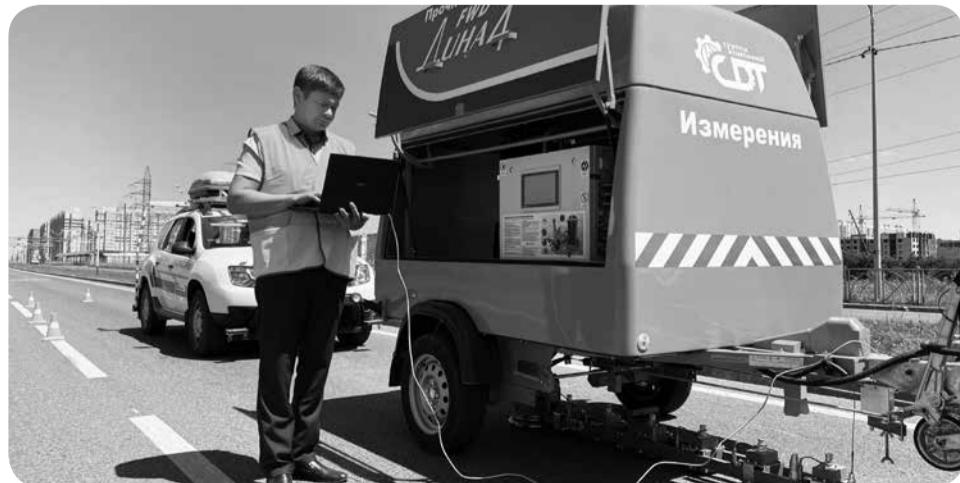
Новое российское оборудование оценивает качество ставропольских дорог. Фото министерства дорожного хозяйства и транспорта СК.
