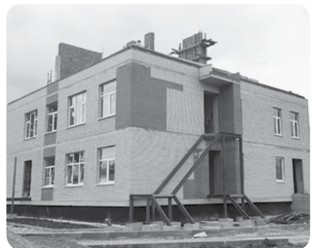
Здание садика готово на 50%. Пуск - в 2022 году.
