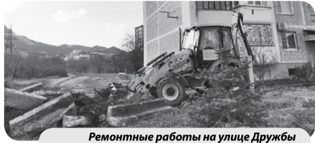
Ремонтные работы на улице Дружбы не останавливаются даже в воскресенье.
