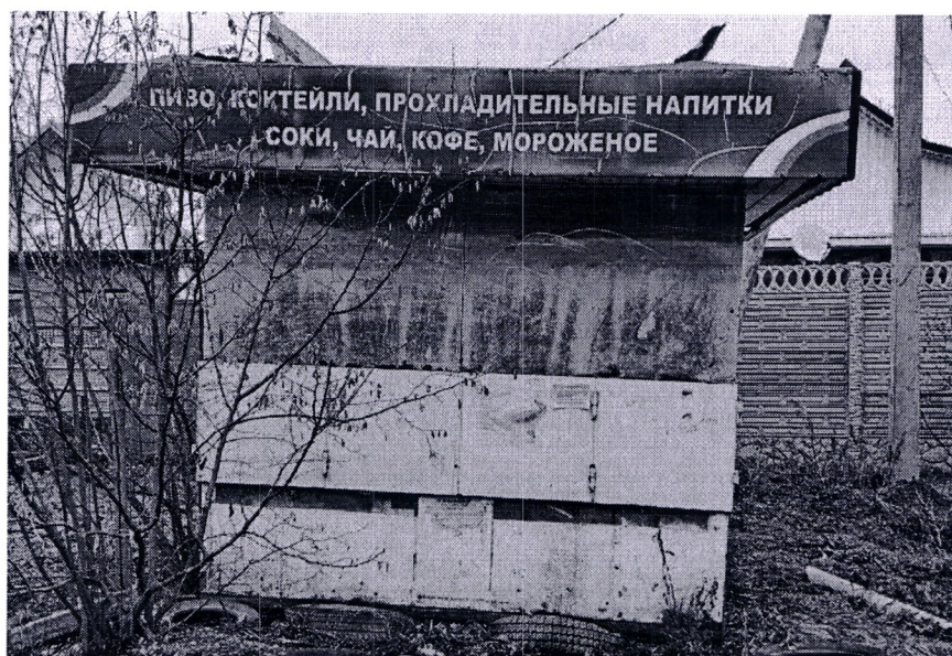
Фото нестационарного объекта
